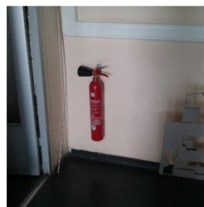
Extincteur B, salle 302
